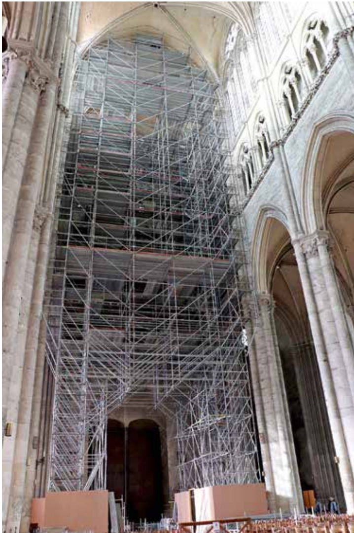
| L'échafaudage pèse 100 tonnes.
